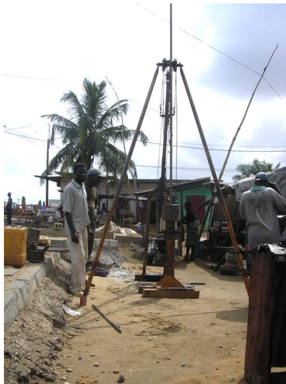
Photo 4 : site n°3 - essais au pénétromètre dynamique le long de la route de Fidjrossè.
