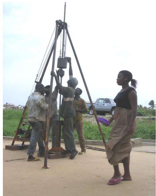
Photo 2 : Le pénétromètre dynamique
