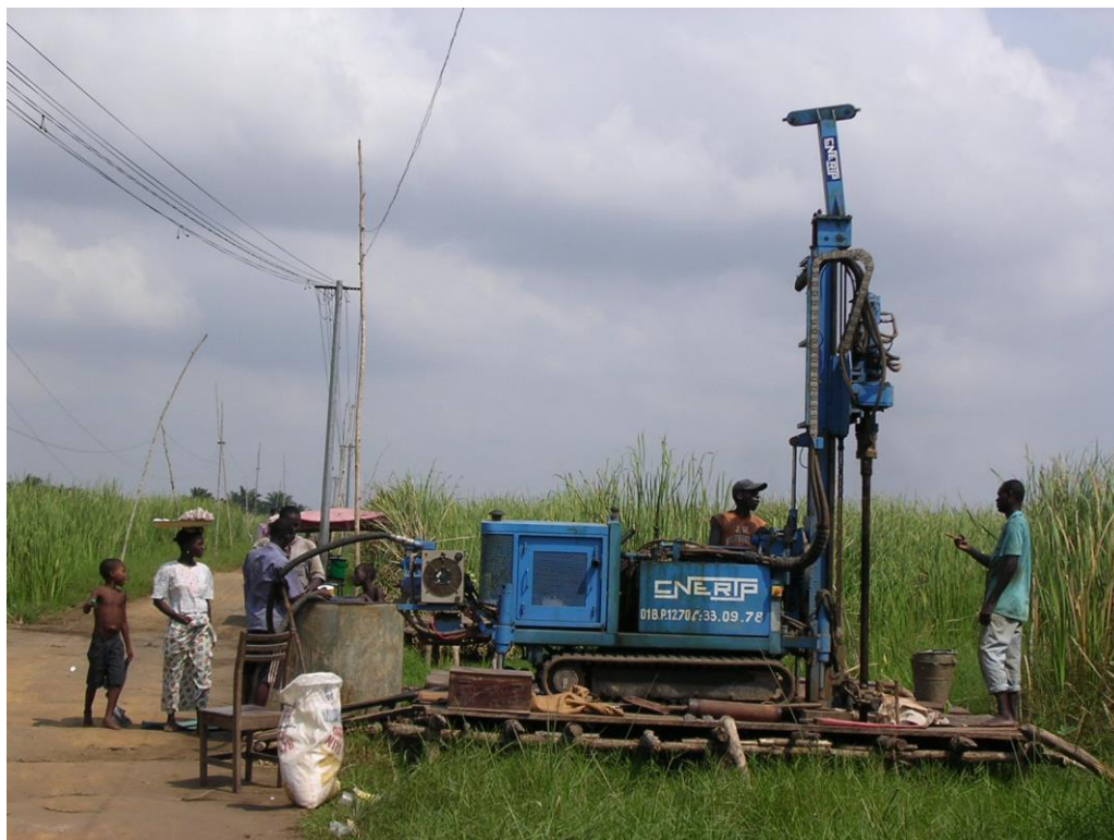
Photo 9 : Sondage carotté au site n°5 (Akogbato)
