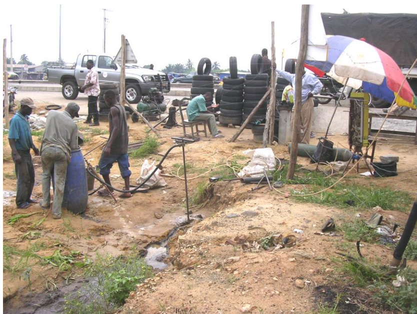
Photo 2 : chantier sur le site n°2 à côté de la route inter-états
