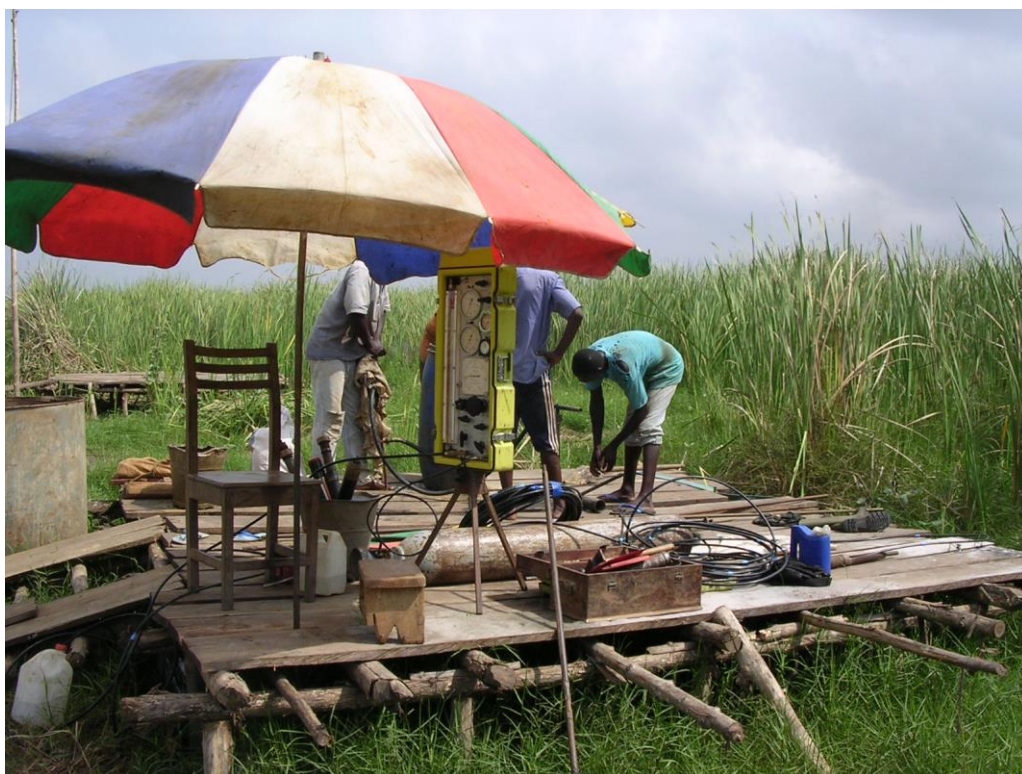
Photo 8: essais au pressiomètre à Akogbato (site n°5)
