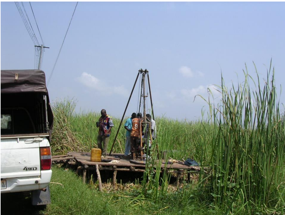
Photo 6 : Essais au pénétromètre à Akogbato (site n°5)
