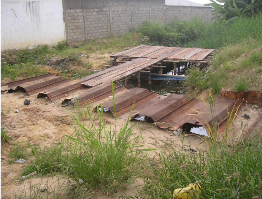
Photo 3 : site n°2 - passerelles et plate-forme au dalot de la route inter-états
